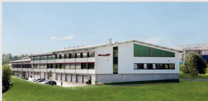
Das Firmengebäude mit 4500 qm Nutzfläche wurde in drei Bauabschnitten zwischen 1995 und 2008 erstellt.
